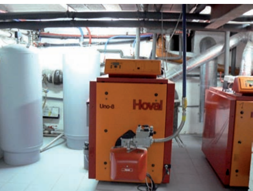
De g. à d. : la chaufferie est dimensionnée pour pouvoir chauffer un volume d'eau important en période de pointe (700 cycles/jour). 3 calandres permettent de repasser sur place le linge lavé. Les machines à laver de 24 kg et les séchoirs correspondants enregistrent un grand succès.
